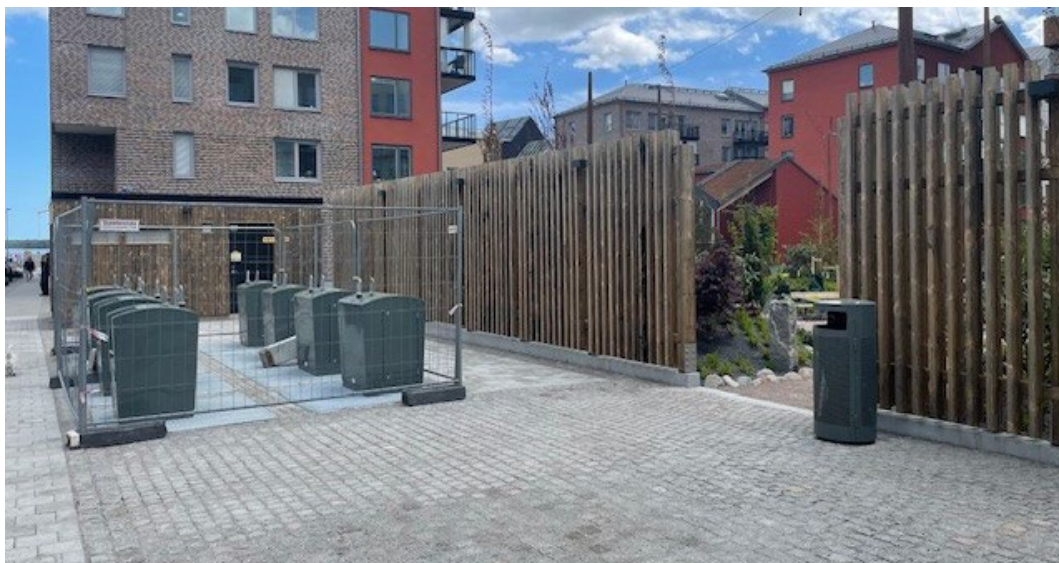
Figur 22 Bild över Siloparkens entré från Östra Rögårdsgatani med nybyggd station för insamling av förpackningar och returpapper från hushåll och en transformatorstation längst bort i vänster i bild. Till höger om parkens entré i bild finns en hårdgjord yta som kan nyttjas vid driftsstopp vid insamlingsstationen eller för tillfällig insamling av grovavfall från hushåll.
