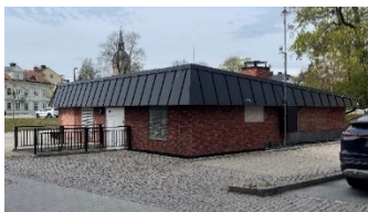
Figur 43 Foto över befintlig pumstation från Ångbåtsgatan i syd.
