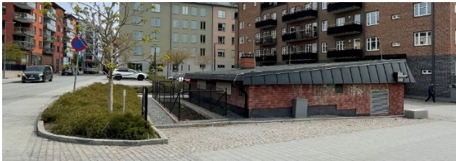
Figur 44 Foto över befintlig pumstation från Östra Rögårdsgatan i norr. Här ser man anläggningens barkfilter omgiven av staket.
